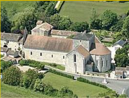
1. Vue générale depuis le sud.
