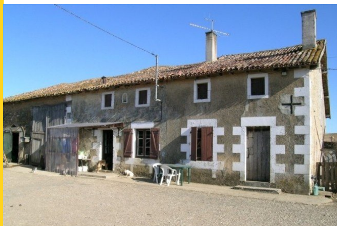
Ferme : ancien bloc en longueur à deux logements prolongés par une grange.
