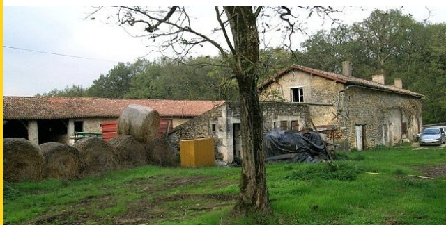
Ferme à bâtiments séparés et hangar à piliers circulaires en moellons (à gauche) © Région Poitou-Charentes - CAP / G. Renaud, 2005.
