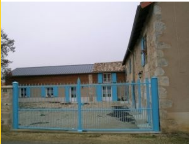
Ferme à cour fermée et bâtiments en L, 22 rue du Puy-Joubert. © Région Poitou-Charentes - CAP / C. Bunoz.
