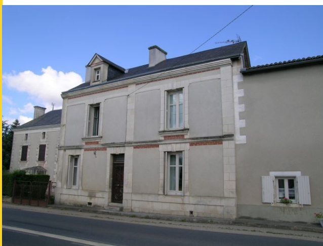
Façade à décor en pierre et en brique, avec corniche, appuis et bandeau moulurés,
