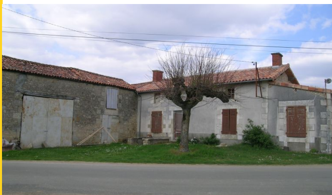
Ferme de plan en L, avec grange à façade en gouttereau, à Tronc. © Région Poitou-Charentes - CAP / Y. Suire, 2006.
