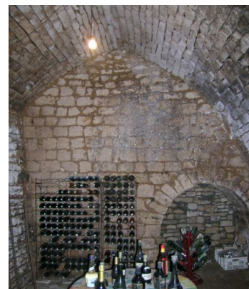
Une cave sous une ancienne ferme, à Ensoulesse.
