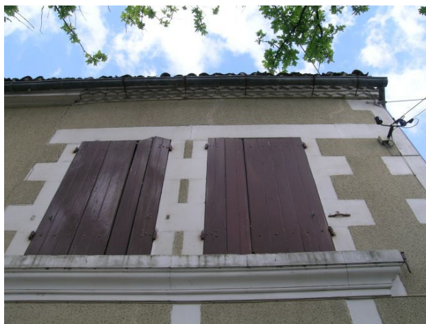
Appui mouluré et génoise (au sommet de la façade) à Charassé. © Région Poitou-Charentes - CAP / Y. Suire, 2006.
