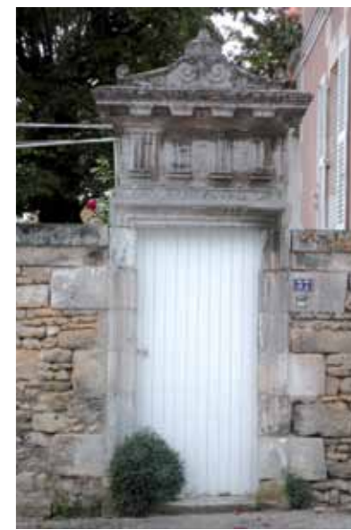
Porte piétonne couverte d'un fronton orné de volutes et d'éléments de sculpture - Rue de Saumur
