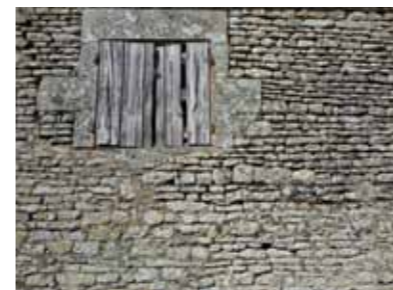
Mur d'habitation en moellon
