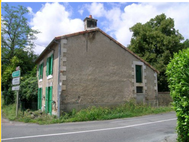
Maison construite en moellons enduits, avec angles et encadrements en pierre de taille, à la Vallée des Touches. © Région Poitou-Charentes - CAP / Y. Suire, 2007.
