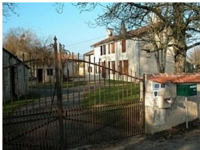
Ancienne ferme à bâtiments séparés, à la Maison-Bruleau. © Région Poitou-Charentes - CAP / G. Renaud, 2005.
