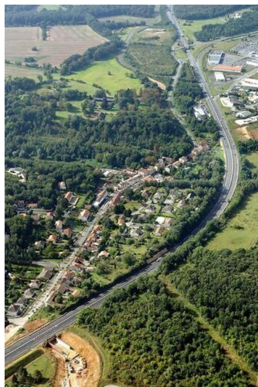
Vue aérienne du village, traversé par l'ancienne route nationale 10 et sa déviation à droite. © Région Poitou-Charentes - CAP / R. Jean, 2007.
