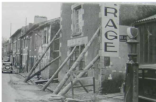
Maison de bourg et boutique, aujourd'hui détruites, 52 Grand-Rue
