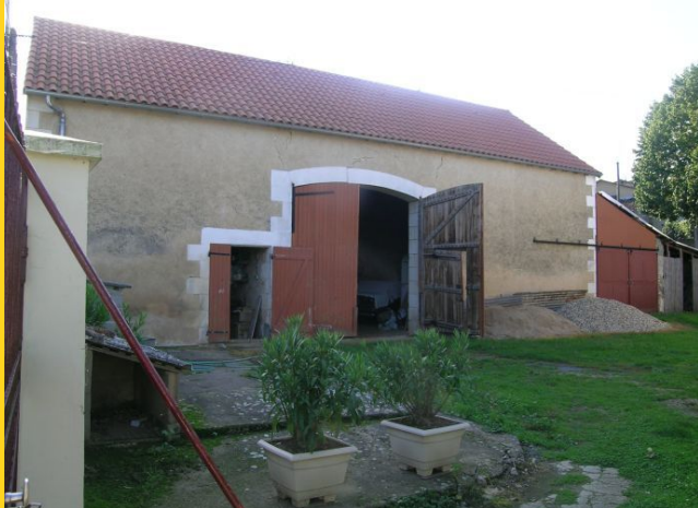
Grange à façade sur le mur gouttereau, à la Vallée. © Région Poitou-Charentes - CAP / Y. Suire, 2006.
