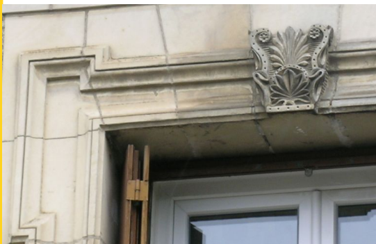
Encadrement saillant et mouluré, avec une clé ornée, sur une façade de maison à Lessart. © Région Poitou-Charentes - CAP / Y. Suire, 2006.
