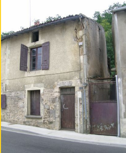
Maison avec un étage et un comble à surcroît, à Lessart. © Région Poitou-Charentes - CAP / Y. Suire, 2006.
