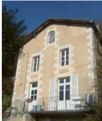
Rue de l'Ermitage, cette maison construite contre le coteau est accompagnée de dépendances dont l'ancien four à chaux mentionné en 1865.
