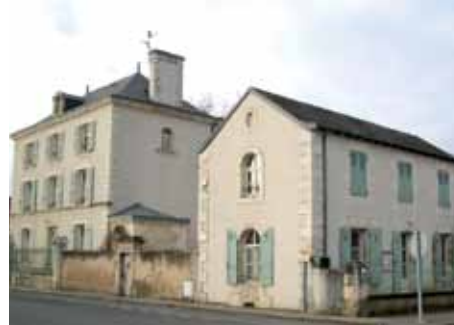
Rue des Ecoles, maisons construites à la fin du XIX e siècle.
