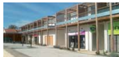
Avenue Charles-De-Gaulle - nouvel espace d'habitation et de commerces de proximité.
