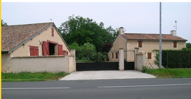
Ferme à bâtiments séparés et grange avec façade en pignon, à la Montagne. © Région Poitou-Charentes - CAP / G. Renaud, 2006.
