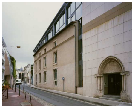
Vue actuelle de la Maison de la Région : à gauche, le bâtiment Irlande et à droite, la porte de l'ancienne église des Jacobins.
