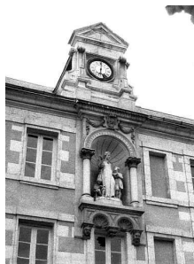
La façade du bâtiment construit au début du XVIII e , photographiée en 1982 : on voit l'horloge et la statue de saint ajoutées en 1902.
